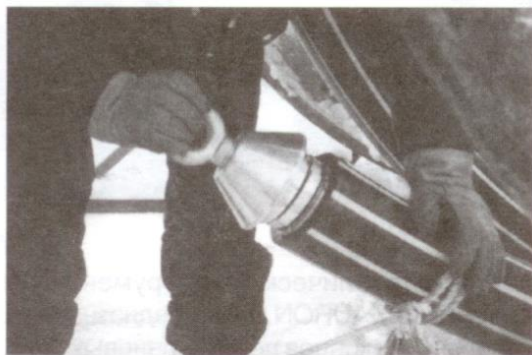
Рис. 3.22. Тянущая головка производства фирмы «J.SAURON.S.A.» в процессе применения
